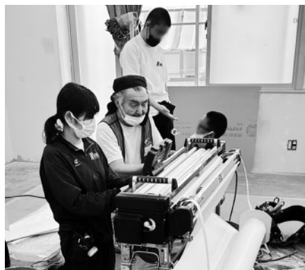
(左・上)クロスの貼り方、パテの塗り方を説明する遠藤さん (下)自動紙糊付け機の使い方を説明する遠藤さん
