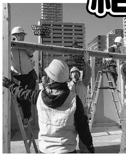
若手組合員が頑張り、上棟式組み
