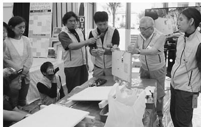
クロス壁の補修
